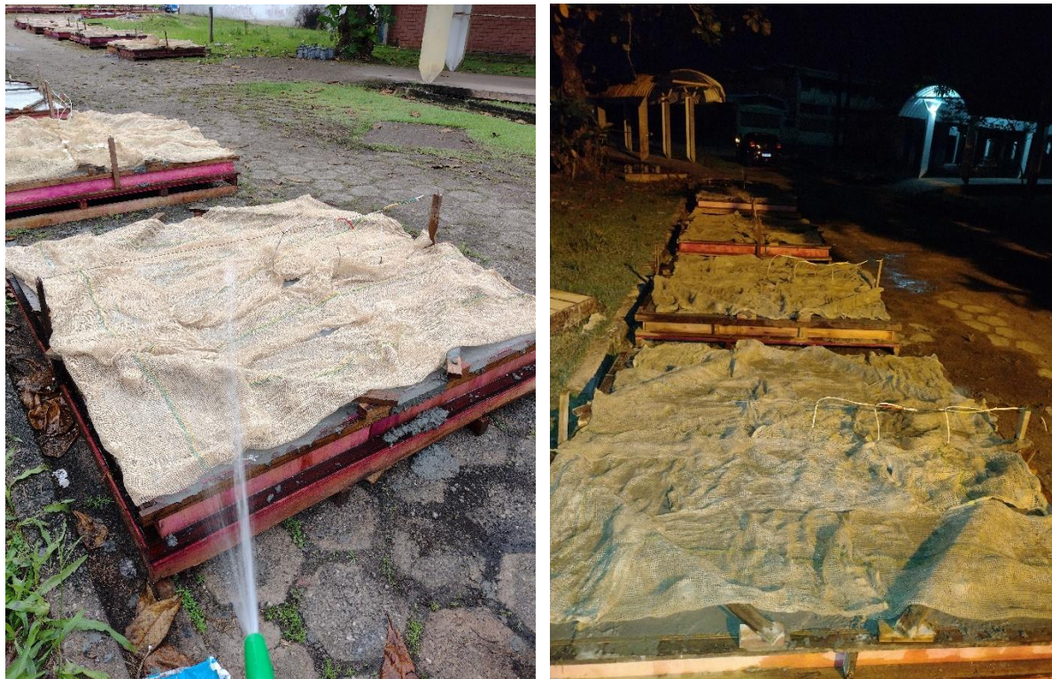
Figura 3.15 - Cura das lajes e dos corpos de prova utilizando sacos de aniagem
