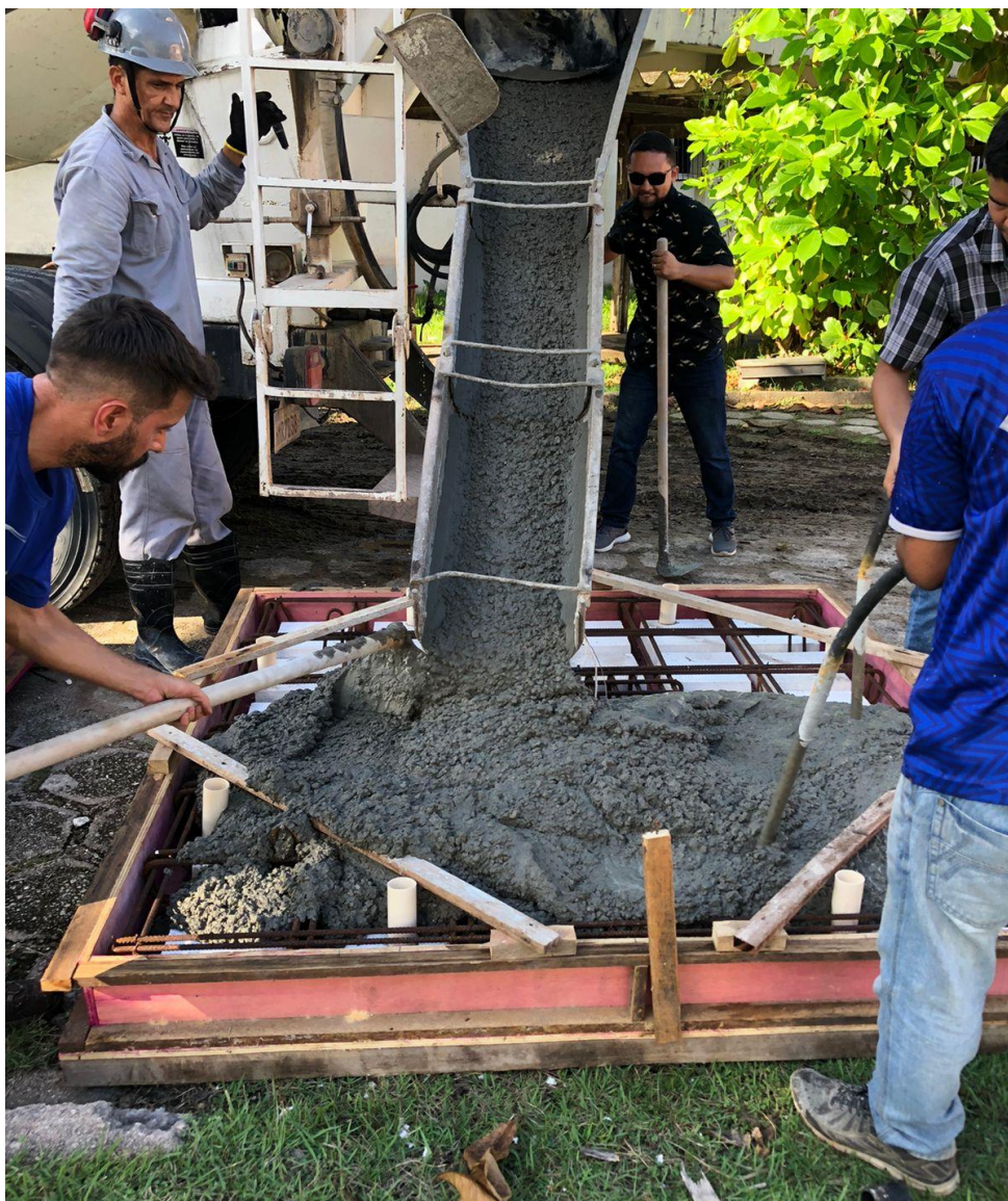
Figura 3.12 - Lançamento do concreto na fôrma
