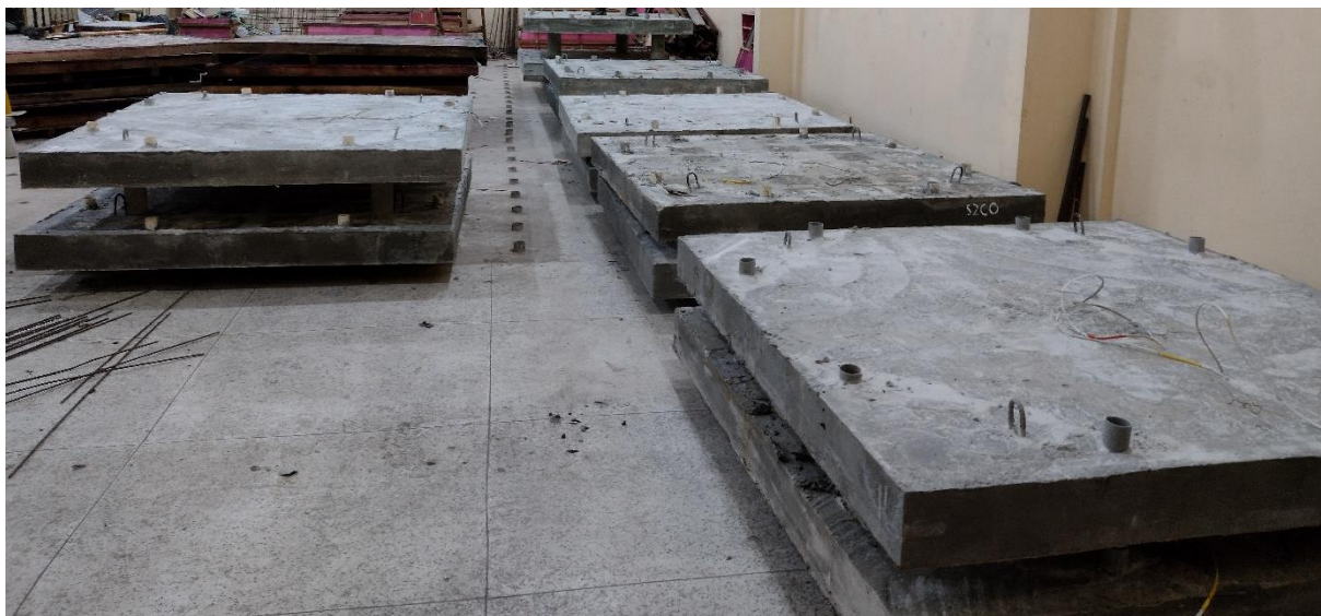
Figura 3.17 – Armazenamento das lajes
