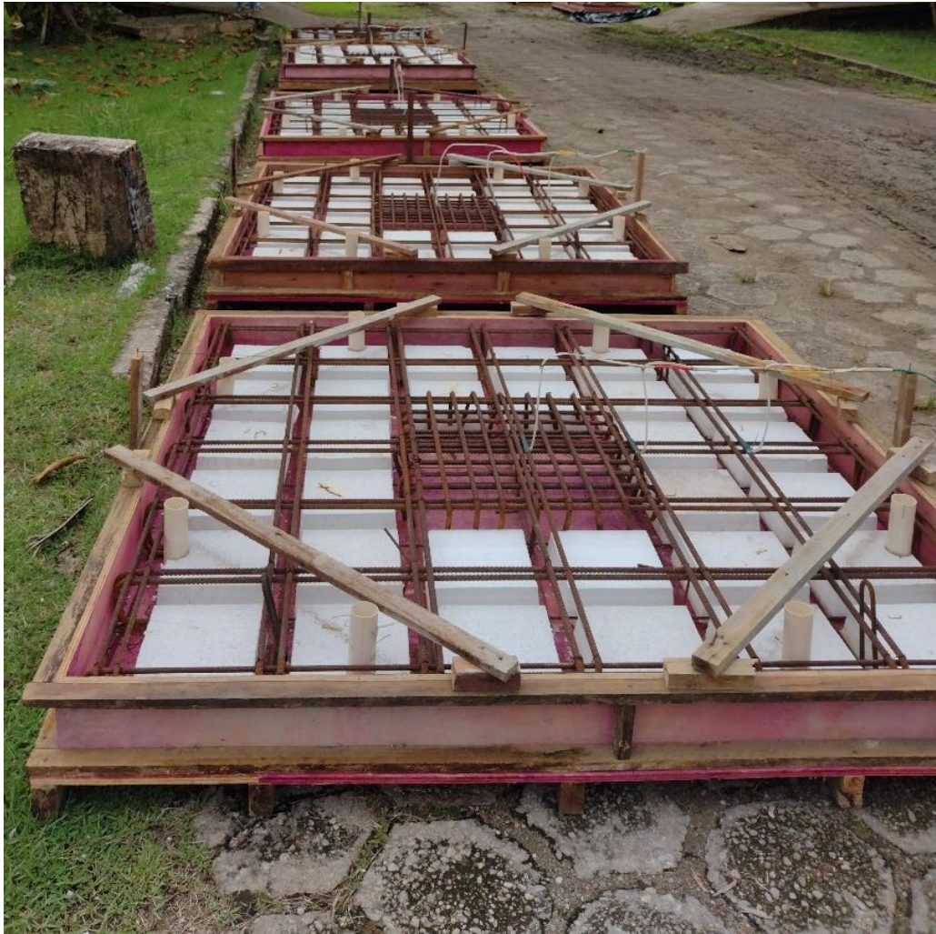
Figura 3.10 - Formas de madeiras utilizadas na confecção das lajes
