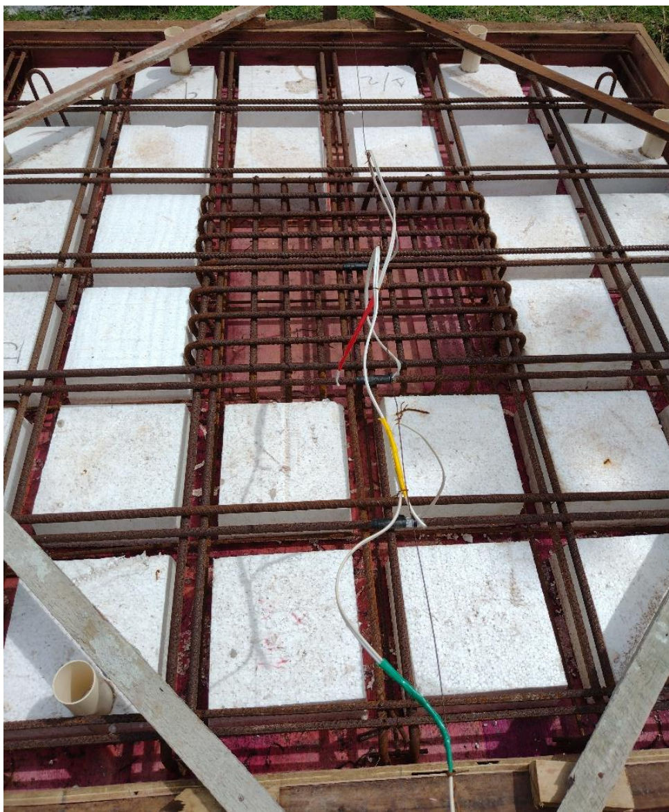
Figura 3.11 - Blocos de EPS fixados à forma
