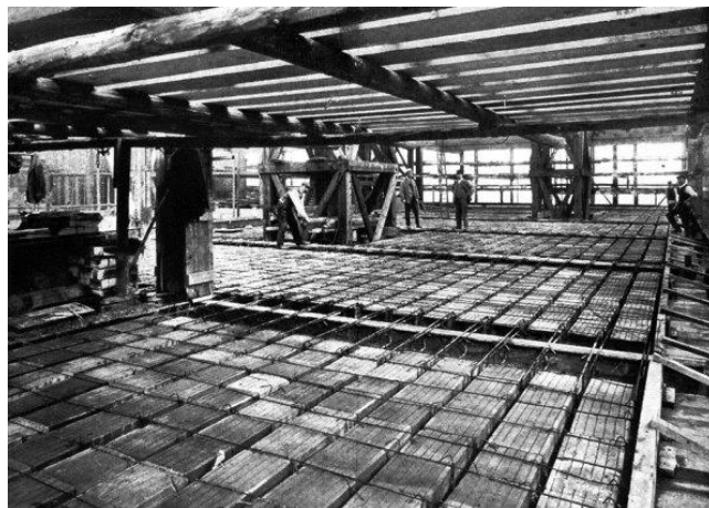
Figura 2.2 - Sistema com lajes nervuradas construídas por Wilkinson em 1854.
