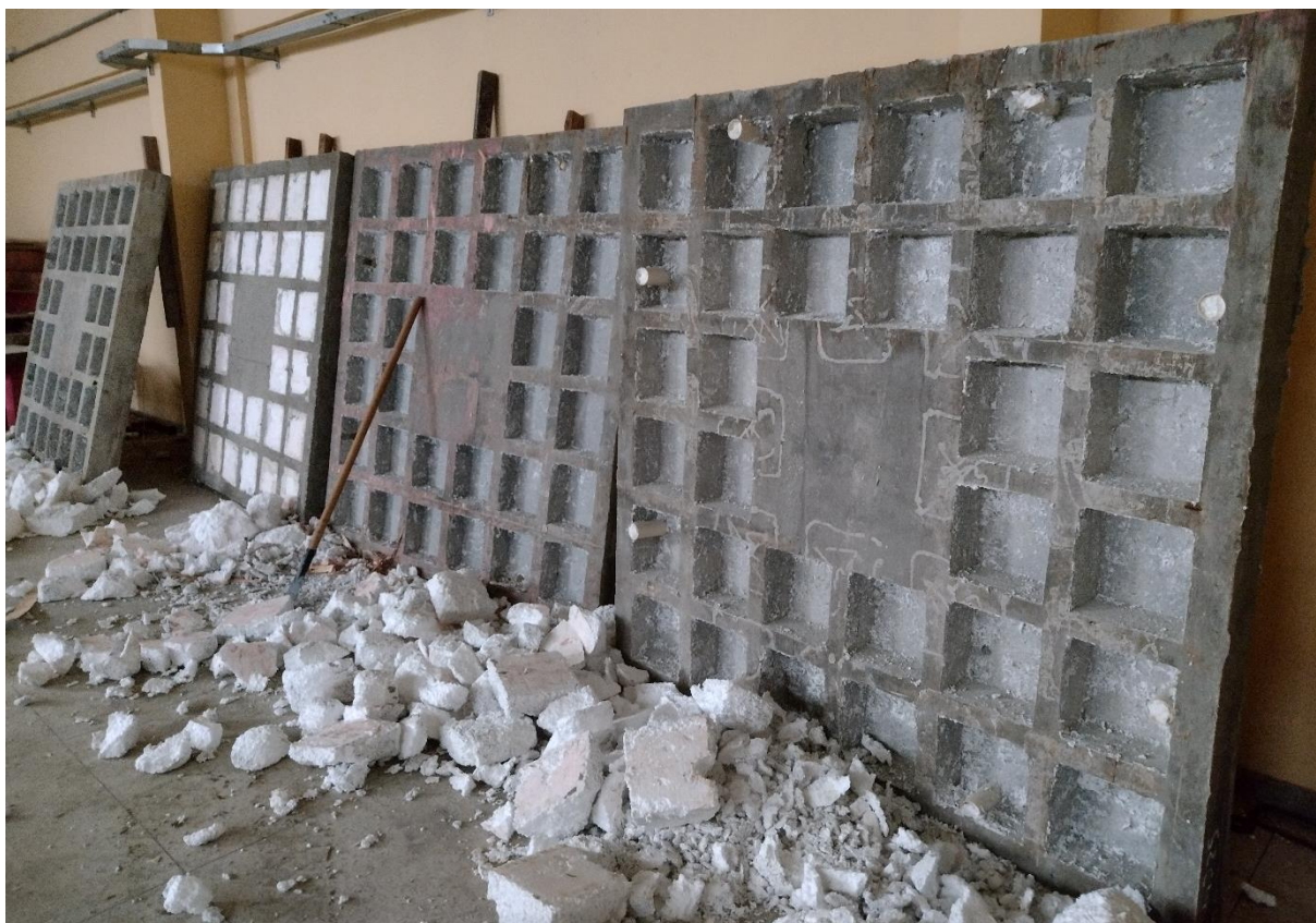
Figura 3.16 - Retirada dos blocos de EPS
