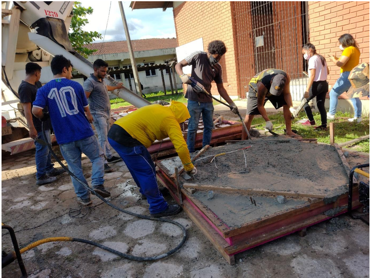
Figura 3.13 - Adensamento e regularização da superfície de concreto
